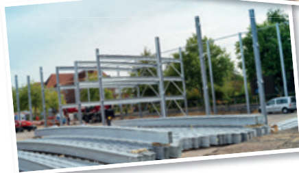
Meilenstein im Bau ist das Richtfest mit traditioneller Richtkranz
