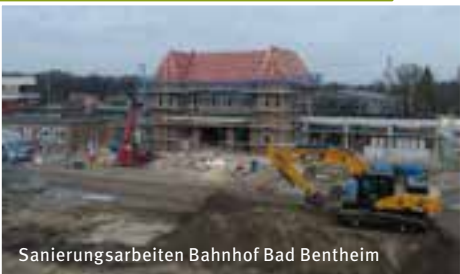
Sanierungsarbeiten Bahnhof Bad Bentheim
