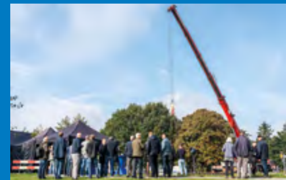
Aushub der Drehbrücke in Coevorden
